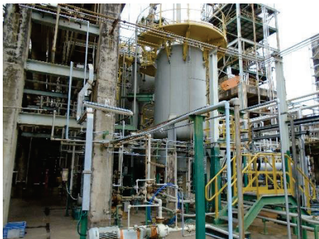
ภาพที่ 2-10 ถัง Waste Catalyst (D110)
