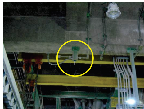
ภาพที่ 2-24 Heat Detector
