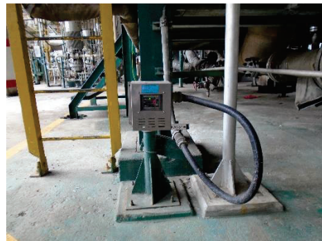
ภาพที่ 2-37 ระบบท่อขนส่ง Vent Gas และ Nitrogen และการติดตั้ง Gas Detector
