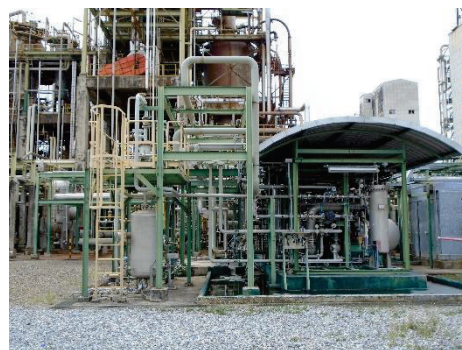
ภาพที่ 2-6 หน่วยนำกลับไอสารไฮโดรคาร์บอน (VOC Recovery Unit: VRU) ของโรงงานที่ 2
