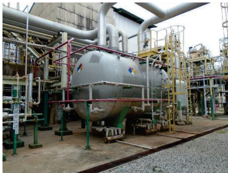
ภาพที่ 2-37 ระบบท่อขนส่ง Vent Gas และ Nitrogen และการติดตั้ง Gas Detector
